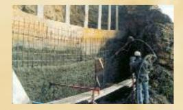
L'entreprise SRMV, sous la maîtrise d'oeuvre de la Direction Départementale de l'Equipement (D.D.E), a réalisé la construction d'un mur en béton projeté pour combler et sécuriser la brèche existante dans ces remparts sur le Chemin des Remparts. Ce mur sera ensuite habillé avec des pierres de récupération provenant de l'ancienne cave vigneronne de façon à assurer la continuité esthétique des remparts.
